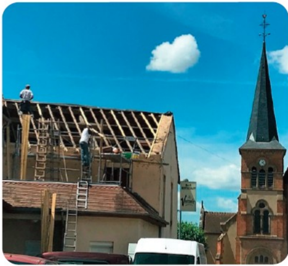
Réfection de la toiture du restaurant réalisée par l'entreprise Bidet : 4 536€HT
